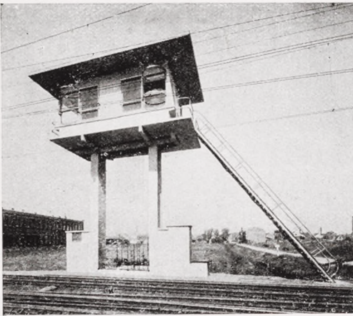
Cabine de signalisation à Delft.
